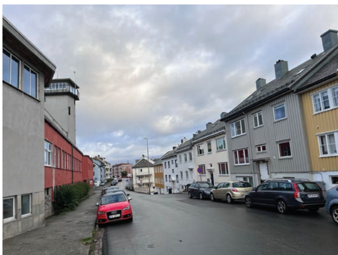
Bilde av parkeringssituasjonen i Huggaa ved brannstasjonen
