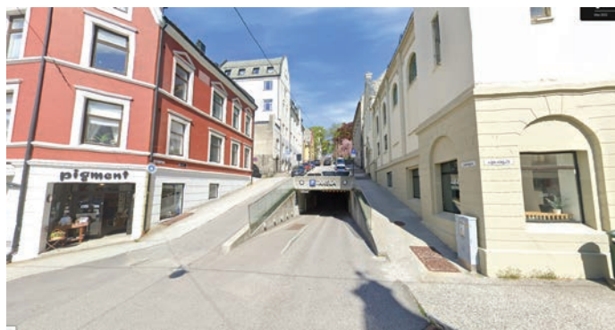
Bildet viser innkjøring til Aksla parkeringsanlegg i fjell i Ålesund
